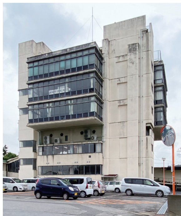
写真1 2023-05-29 旧館林市庁舎全景 (撮影：著者)
