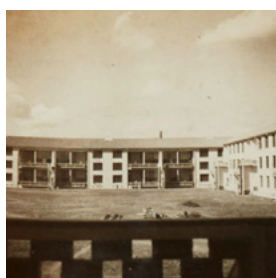
写真9 東棟から西棟を見る (台紙85)
