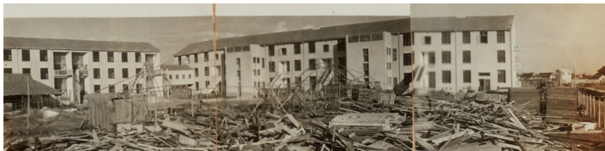
写真3 東社宅工事中の中庭、正面は東棟(B型)の西面(台紙79)
