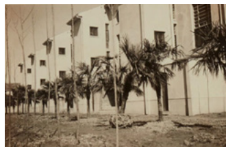
写真5 A型棟西面外観 (台紙92)
