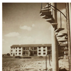
写真10 北棟外部螺旋階段 下から西棟を見る (台紙85)
