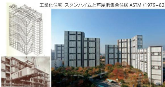
メタボリズムの延長線上で内装・設備まで建築ユニットをメーカーで製造し、家ごとトラックに載せて移動・挿入することで建設・引越しの概念が実行された。ASTMでは5層ごとのメガトラス階に空中公園が設けられた。振動解析で用いられた地震力は2次設計時PGA 400galであったが、風振動に対する設計は不十分であった。
