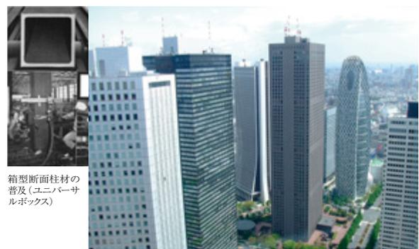
図24 超高層建物の一般化とボックス断面鋼柱の普及
