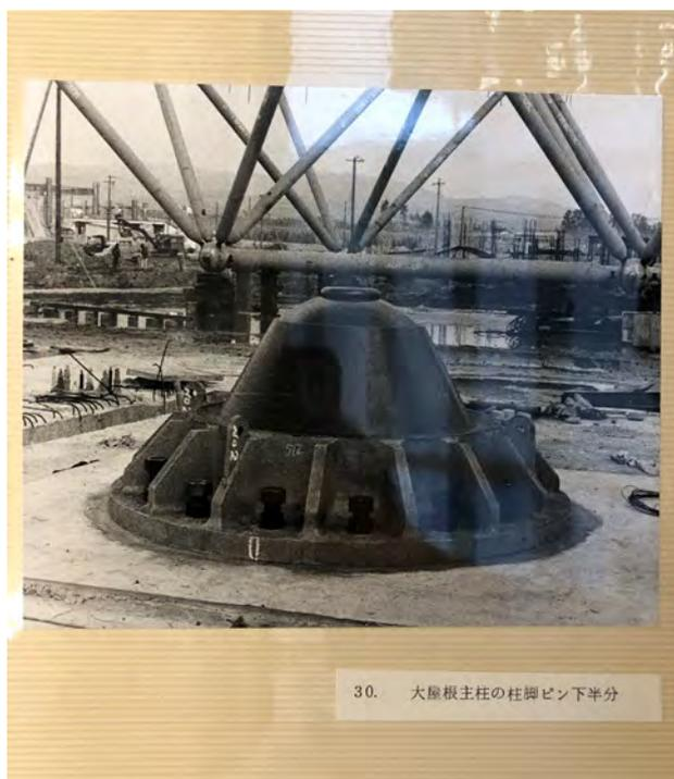
30. 大屋根主柱の柱脚ピン下半分
