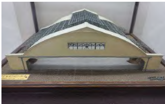
模型(ダイヤモンドトラス, A Type, 40x30m, 1/100, 初期の格納庫)
