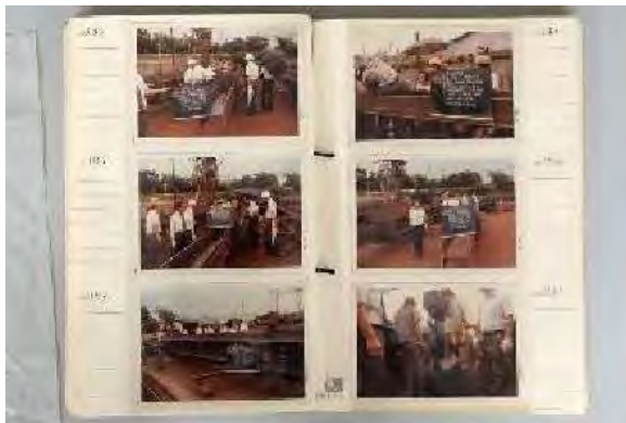
電通大阪ビル 製品検査
