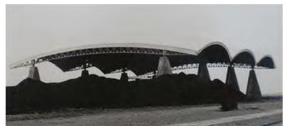
東北電力八戸火力貯炭場現場写真3
